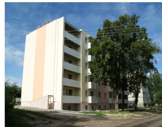
ООО «Репер» г. Барыш, ул. Пушкина Строительство жилого дома с помещениями общественного назначения
