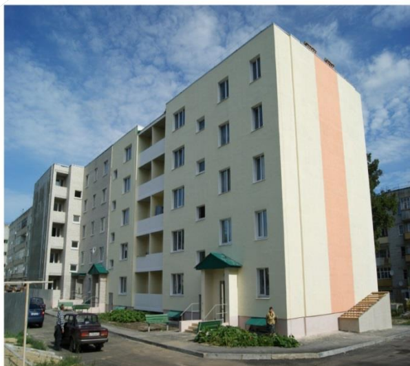
ООО «Репер» г. Барыш, ул. Пушкина Строительство жилого дома с помещениями общественного назначения
